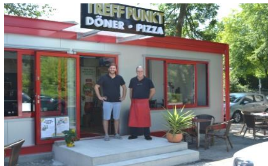
Treffpunkt Imbiss Ersatz des baufälligen Gebäudes, Erhalt des Treffpunktes
